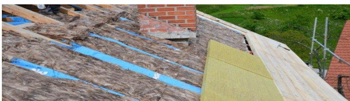
Slika 9. Izolacija krovišta kamenom vunom[13]
