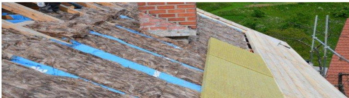
Slika 9. Izolacija krovišta kamenom vunom[13]
