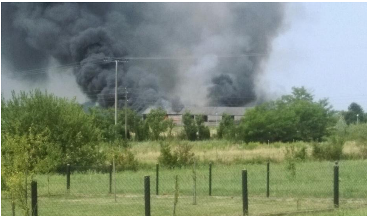
Slika 11. Požar skladišta s udaljenosti od 300m[15]
