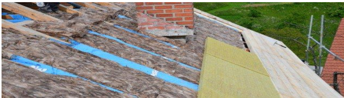
Slika 9. Izolacija krovišta kamenom vunom[13]
