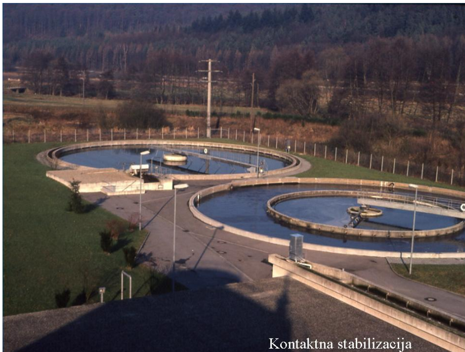
Slika 17. Bazen za kontaktnu stabilizaciju
