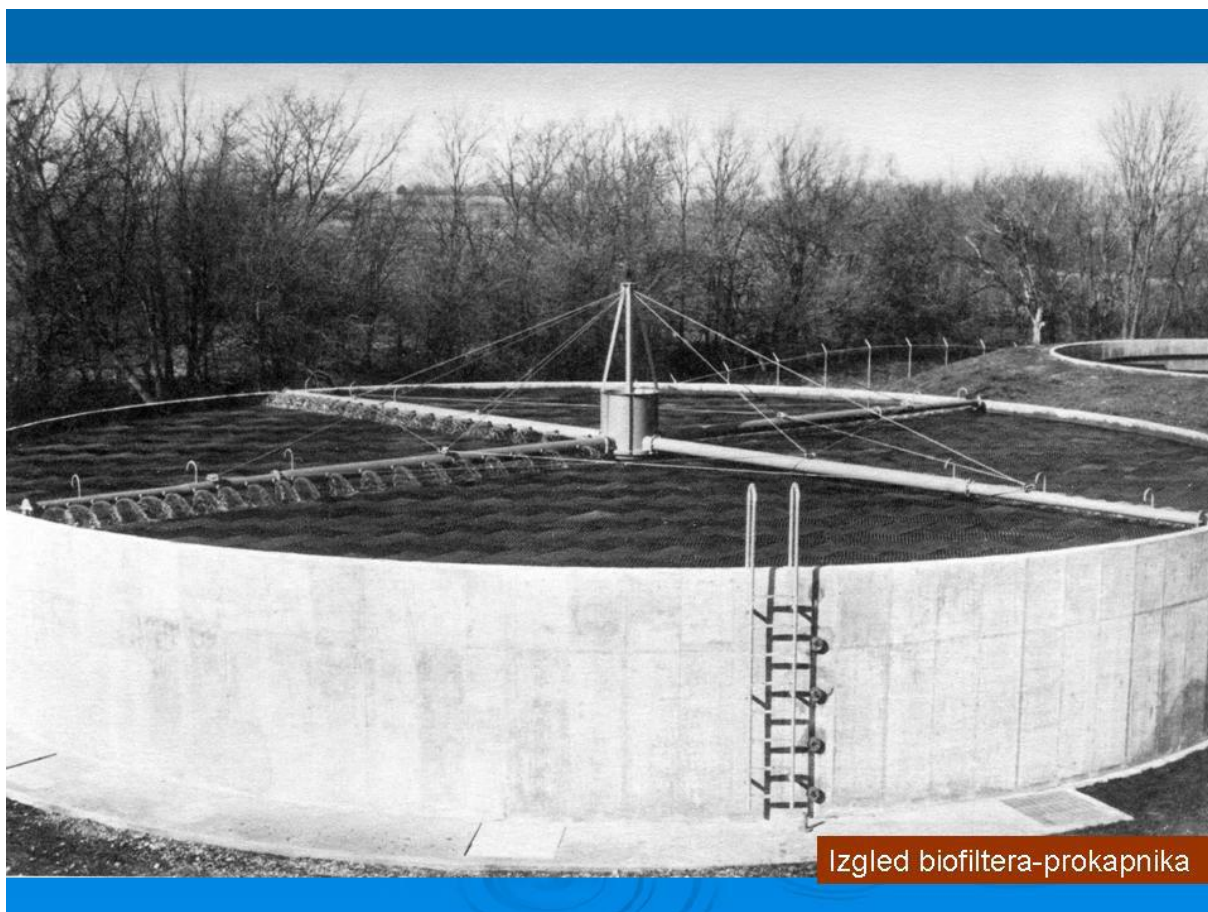
Slika 18. Izgled biofiltera
