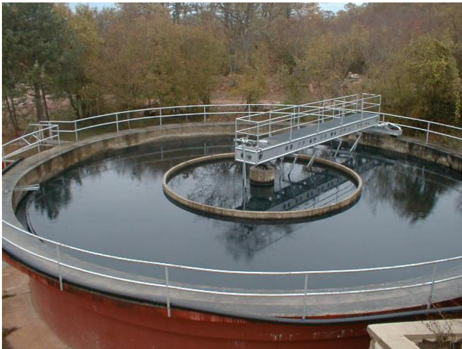
Slika 14. Bazen za flokulaciju
