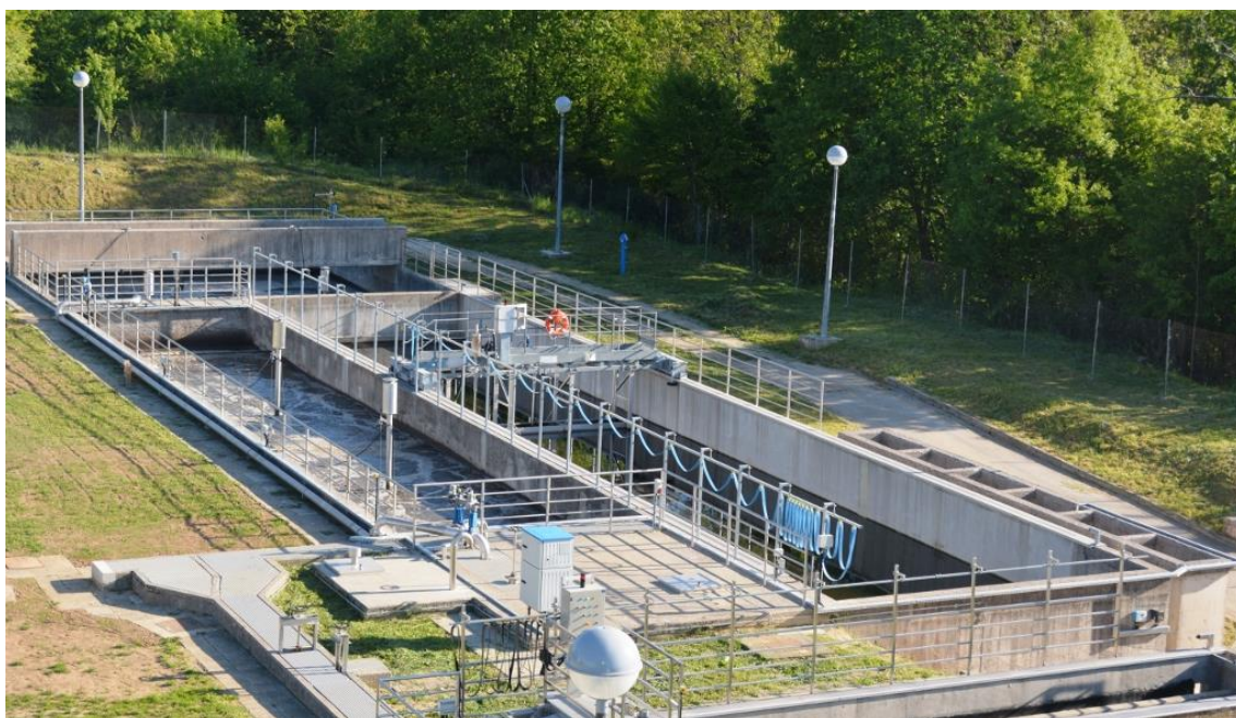
Slika 6. Uređaj za pročišćavanje otpadnih voda
