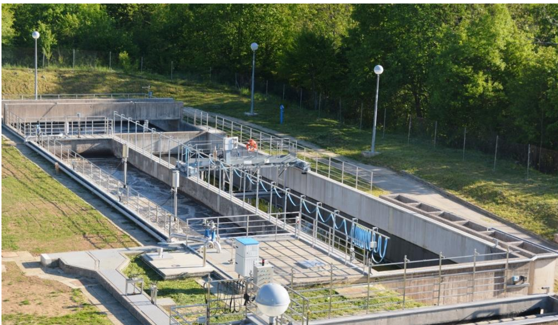
Slika 6. Uređaj za pročišćavanje otpadnih voda
