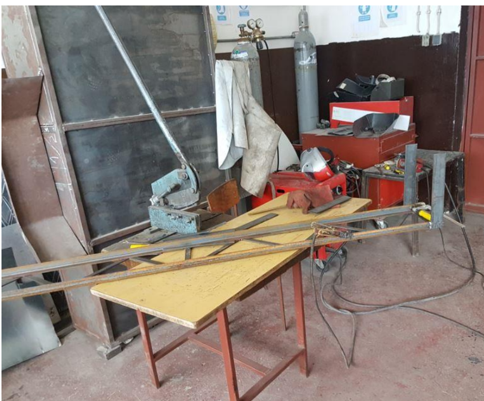
Slika 65.: Početak zavarivanja nosive konstrukcije
