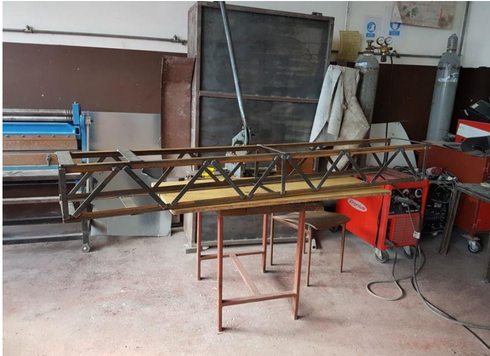
Slika 66.: Zavarivanje stranica konstrukcije
