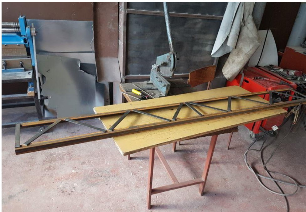
Slika 64.: Postavljanje rešetkastog nosača nosive konstrukcije
