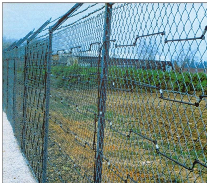
Slika 7. Prikaz načina postavljanja senzorskog vodiča na ogradu
