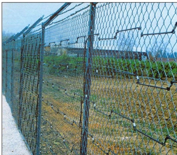
Slika 7. Prikaz načina postavljanja senzorskog vodiča na ogradu
