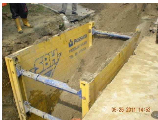
Slika 9. Zaštita bočnih strana prilikom iskop [19]
