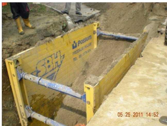
Slika 9. Zaštita bočnih strana prilikom iskop [19]
