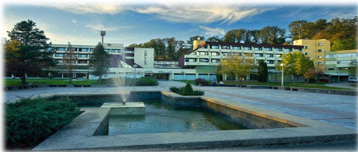
Slika 11. Lječilište Topusko i Top-Terme d.o.o.
