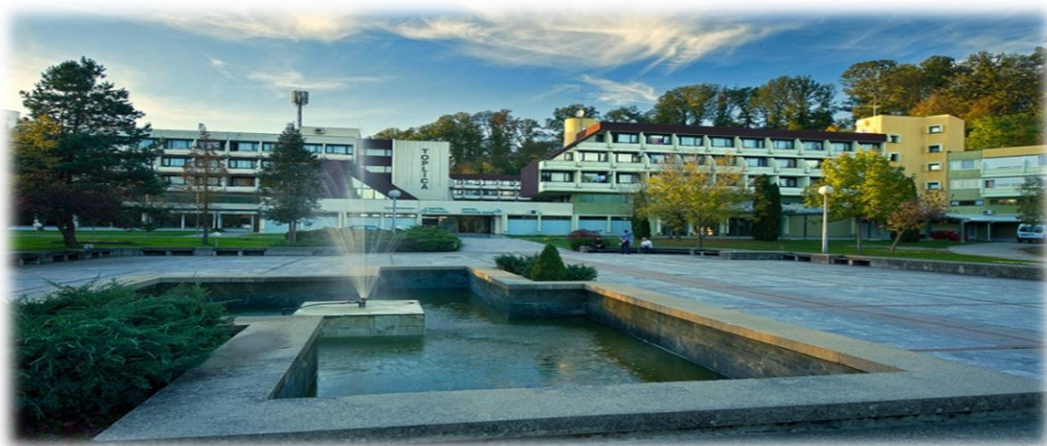
Slika 11. Lječilište Topusko i Top-Terme d.o.o.
