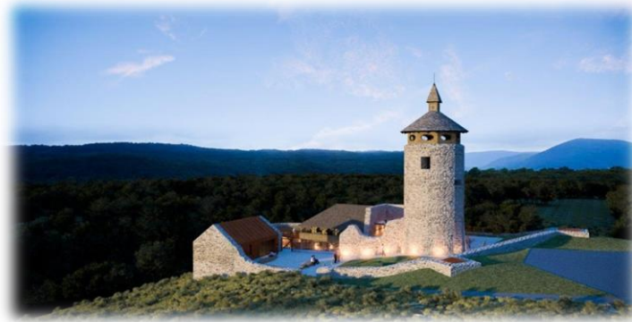
Slika 5. Stari grad Drežnik nakon renovacije
