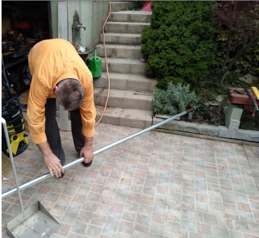
Slika 35. Ručno postavljanje sidrenog cjevastog vijka
