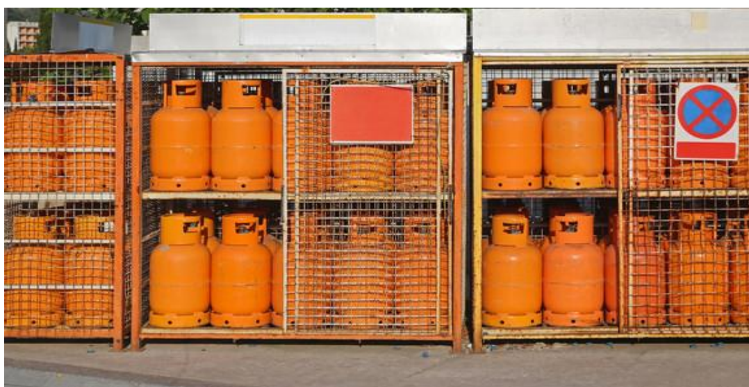
Slika 10. Skladištenje plinskih boca.[22]
