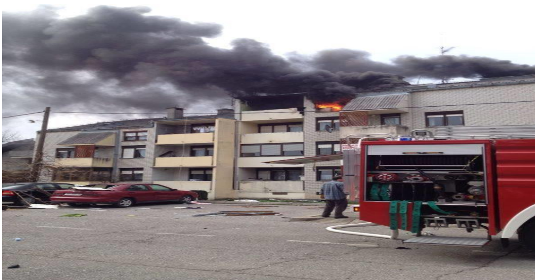
Slika 22. Požar stana u Samoboru nakon eksplozije plina iz plinske boce.[31]
