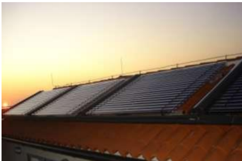
Slika 3.11. Vakuumski kolektori u vodoravnoj izvedbi, Pula [1]
