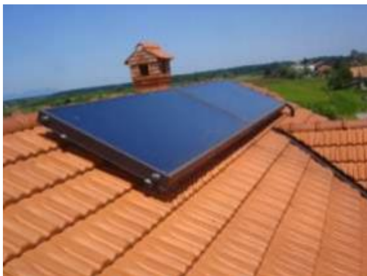
Slika 3.10. Pločasti kolektori u vodoravnoj izvedbi, Vodostaj – Karlovac [1]
