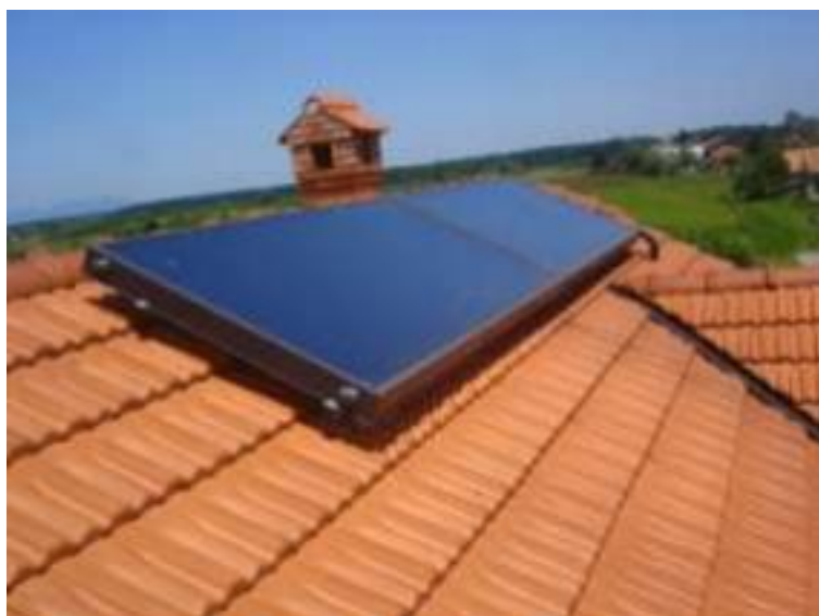
Slika 3.10. Pločasti kolektori u vodoravnoj izvedbi, Vodostaj – Karlovac [1]
