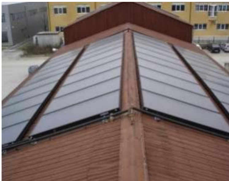
Slika 3.9. Pločasti kolektori u okomitoj izvedbi, Jankomir – Zagreb [1]
