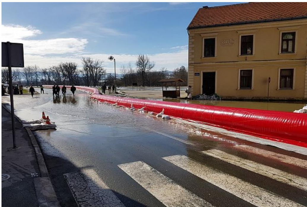
Slika 6 - Sustav vodom protiv vode.[11]
