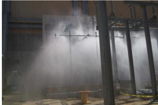
Slika 22. Aktivirani sustav za gašenje vodenom maglom [17]
