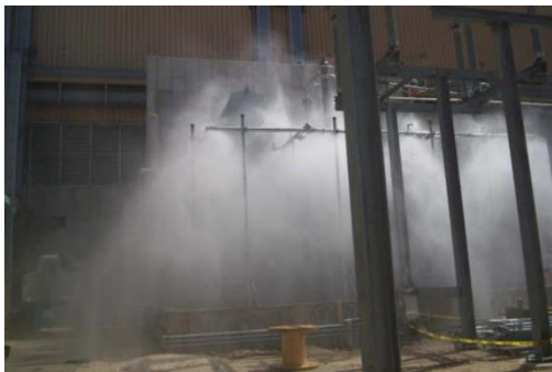
Slika 22. Aktivirani sustav za gašenje vodenom maglom [17]
