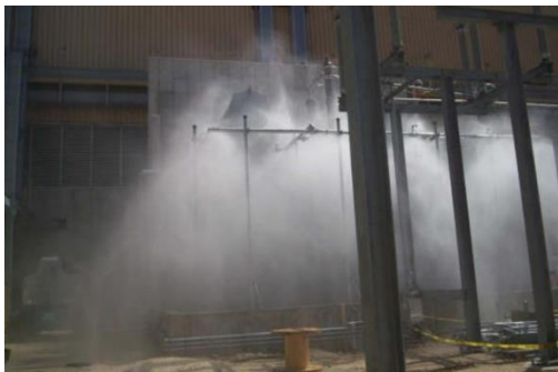
Slika 22. Aktivirani sustav za gašenje vodenom maglom [17]
