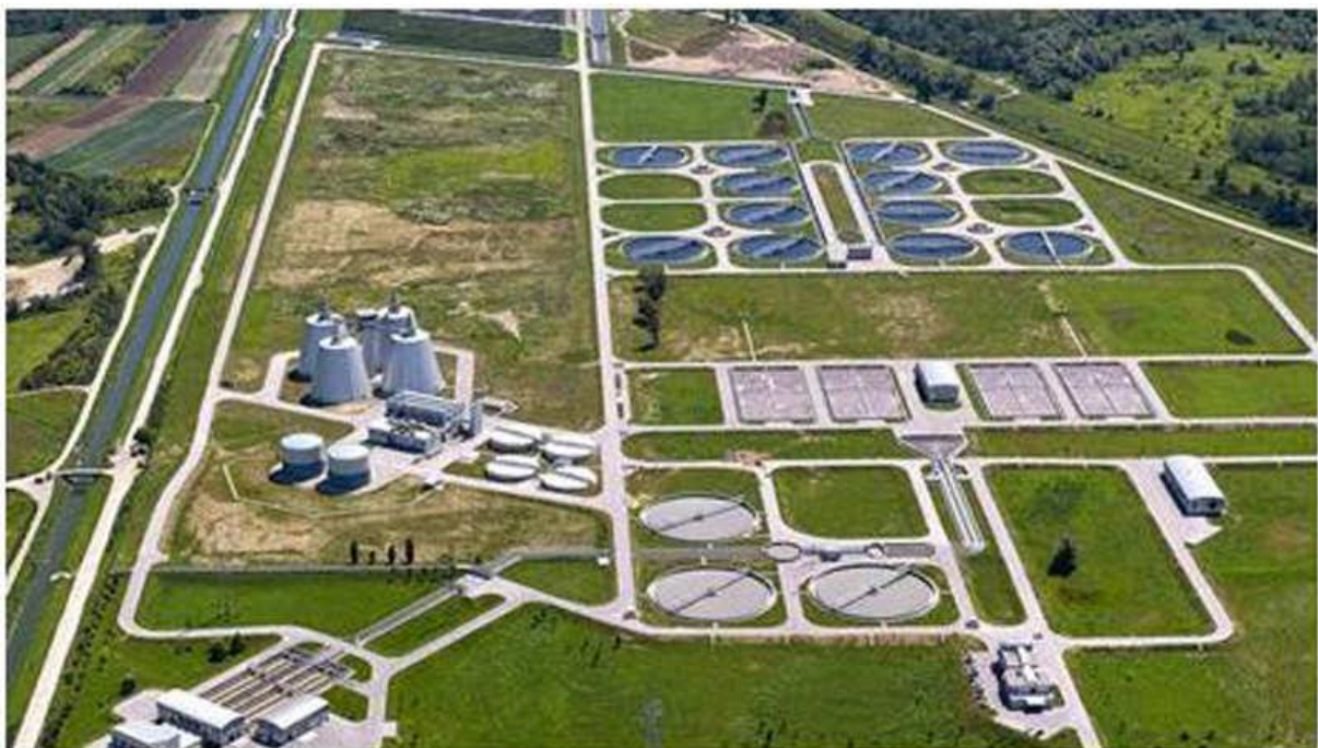
Slika 12. Centralni uređaj za pročišćavanje otpadnih voda Zagreb
