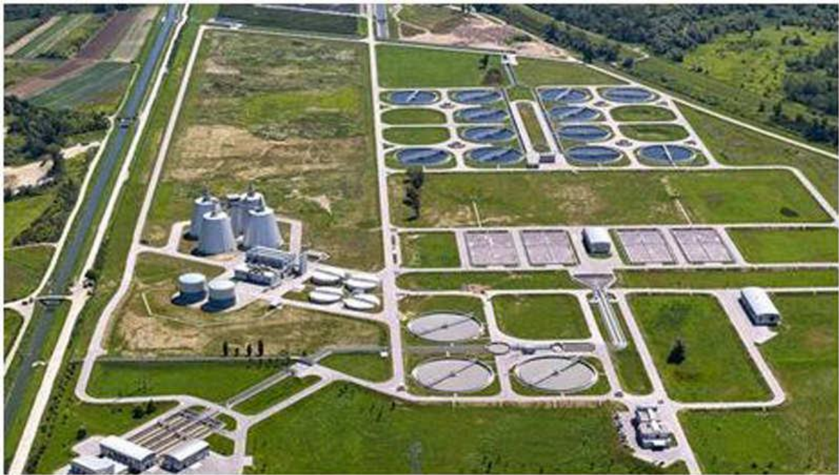
Slika 12. Centralni uređaj za pročišćavanje otpadnih voda Zagreb
