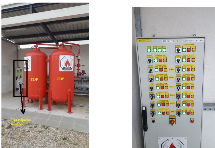
Sl. 13. Poluautomatska aktivacija drencher sustava
