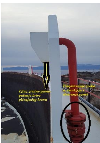
Sl. 9. Zračna komora za tešku pjenu [9]
