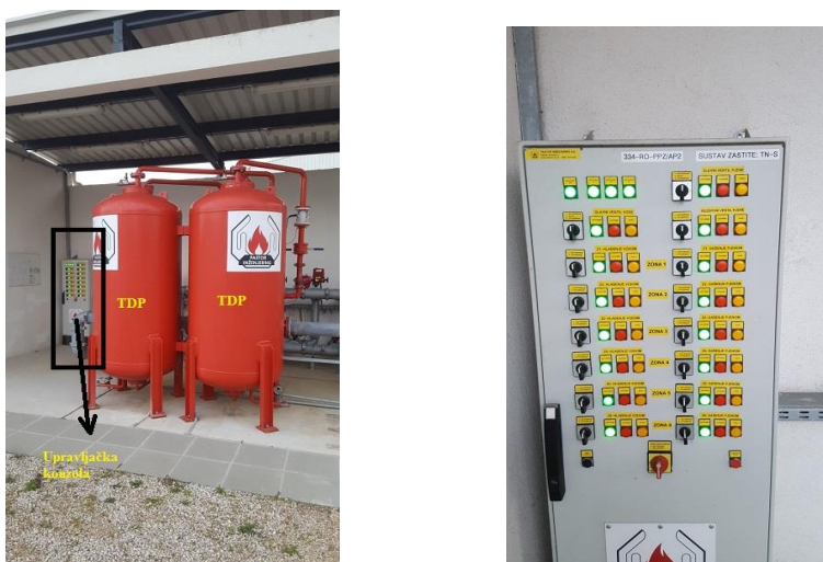
Sl. 13. Poluautomatska aktivacija drencher sustava
