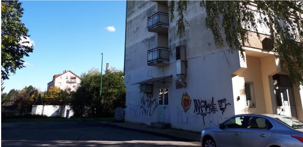
Slika 8. Sjeverna strana perimetra 1
