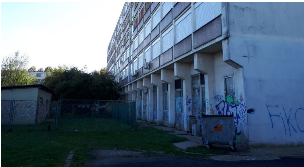
Slika 11. Istočna strana objekta
