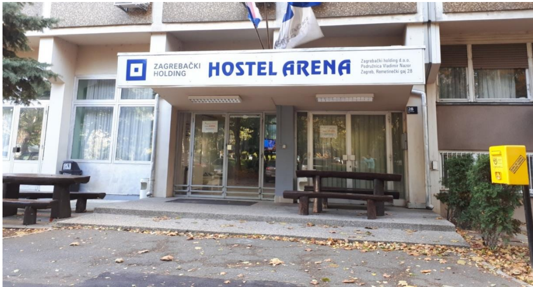
Slika 4. Ulaz u objekt
