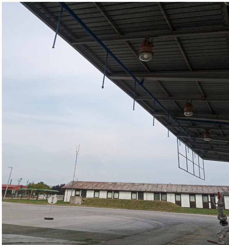
Slika 25 Prikaz drencher sustava auto punilište [14]
