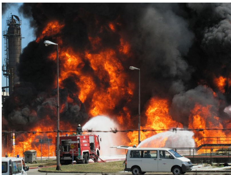
Slika 6. Požar u Rafineriji nafte Sisak [11]
