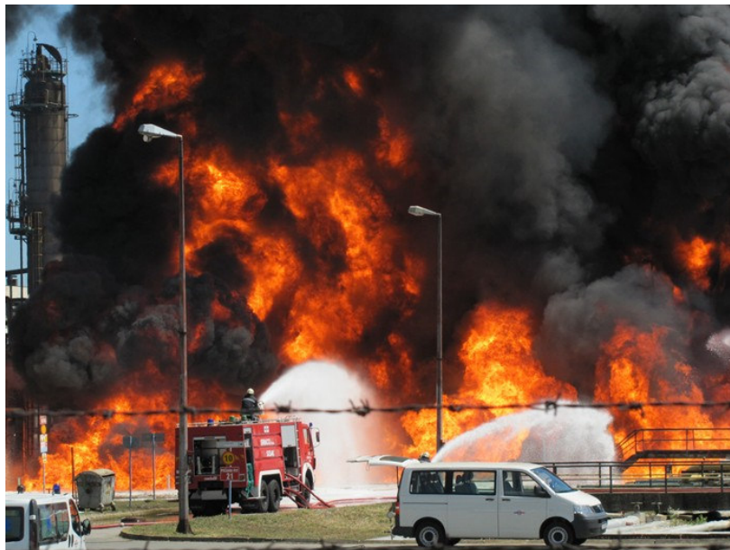
Slika 6. Požar u Rafineriji nafte Sisak [11]
