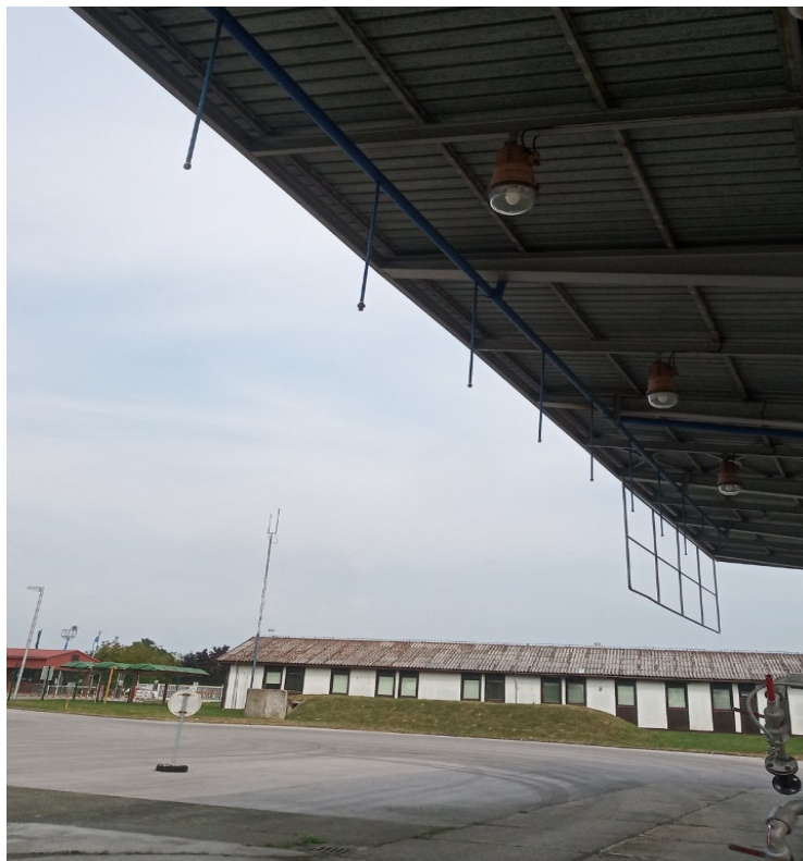
Slika 25 Prikaz drencher sustava auto punilište [14]
