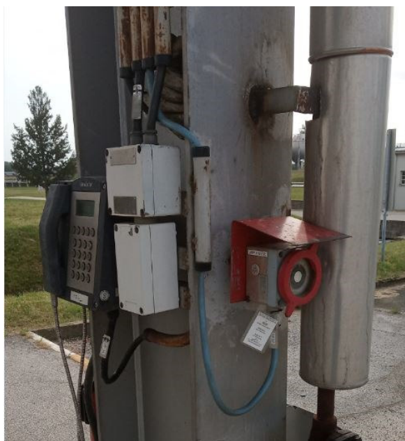
Slika 19. Primjer ručnog dojavnika, [14]
