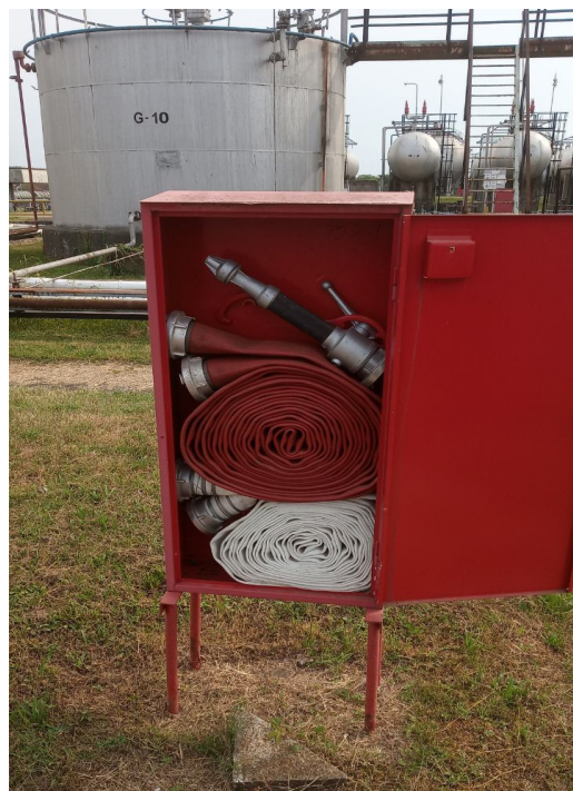
Slika 28. Prikaz hidrantskog ormarića [14]
