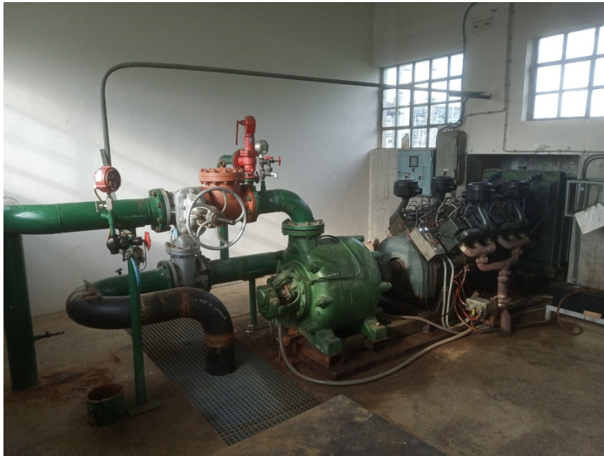
Slika 24 Prikaz rezervnog diesel agregata [14]
