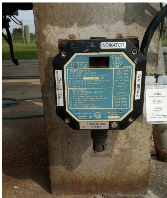
Slika 18. Prikaz mjerne glave [14]
