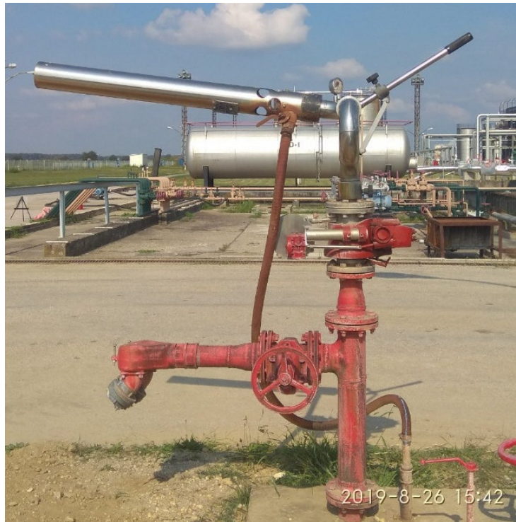
Slika 9. Samooscilirajući stabilni bacač pjene [14]
