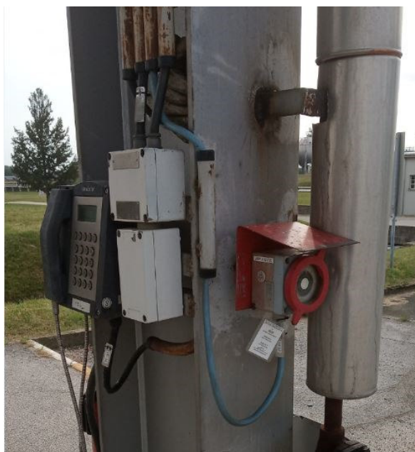
Slika 19. Primjer ručnog dojavnika, [14]
