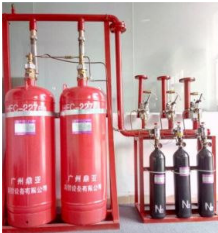
Slika 10 Primjer stabilnog sustava za gašenje požara FM 200, [15]
