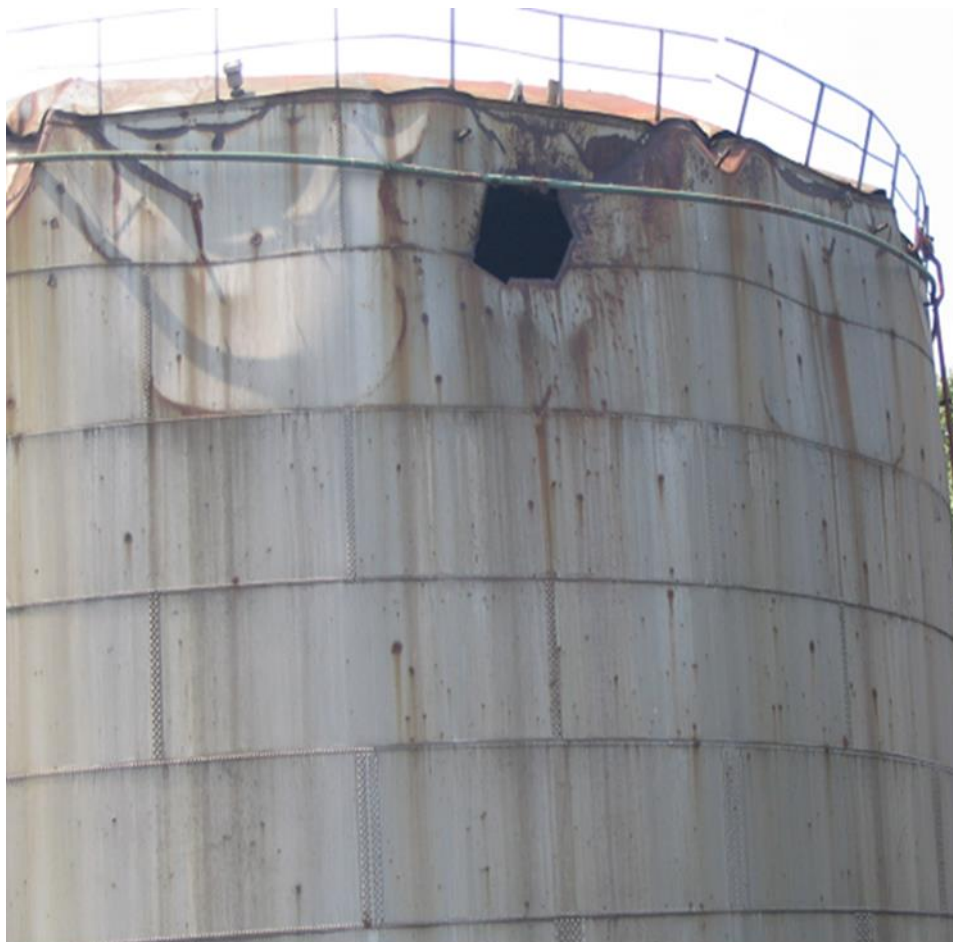
Slika 1. Spremnik nafte pogođen granatom [27]
