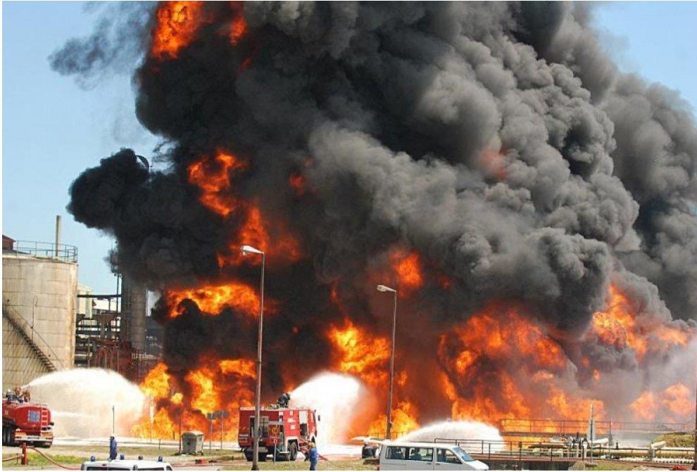
Slika 5. Požar u rafineriji nafte Sisak [31]
