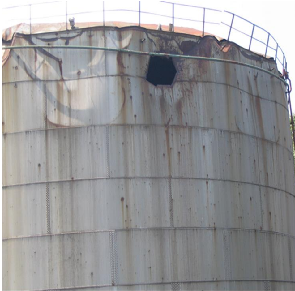
Slika 1. Spremnik nafte pogođen granatom [27]
