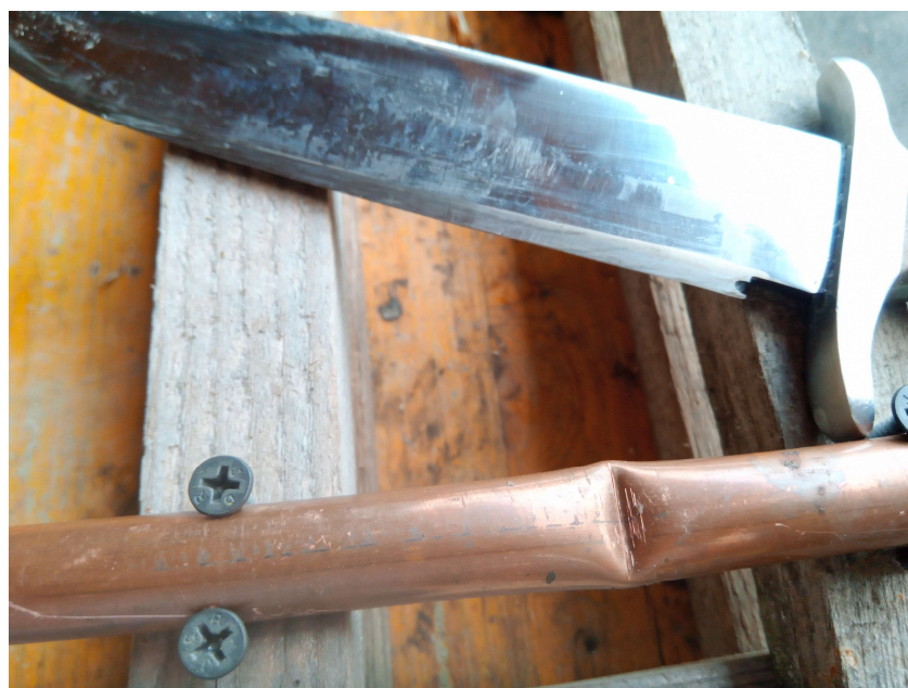
Slika 74 Oštećenja na bakrenoj cijevi i oštrica bez oštećenja (osikro 4)
