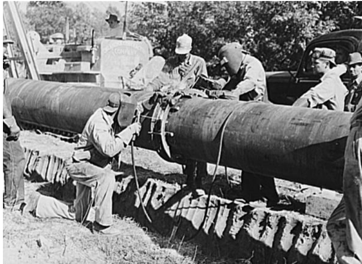
Slika 1. 1942. godina, zavarivanje cjevovoda velikih dimenzija [4]
