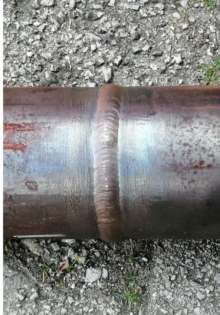
Slika 45. Ispitani sučeoni zavar na cijevnom sklopu
