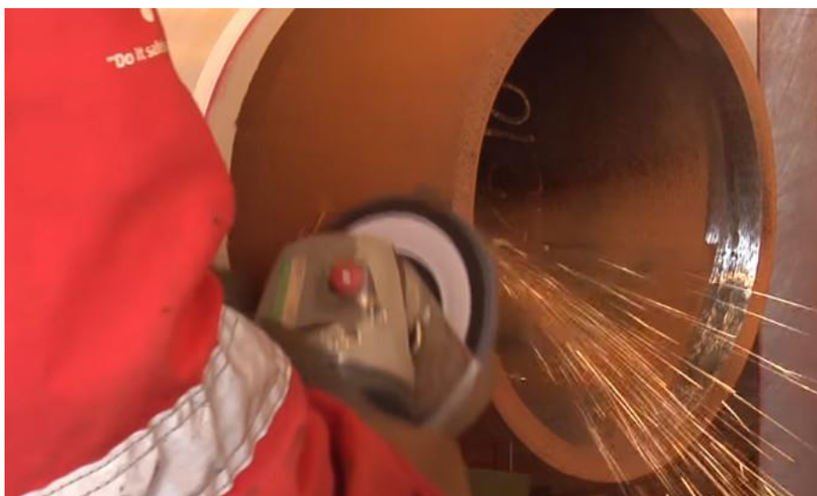
Slika 17. Priprema spoja za zavarivanje – čišćenje od korozije
