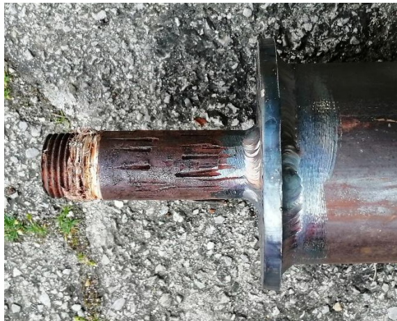
Slika 44. Zavareni spoj grane za punjenje
