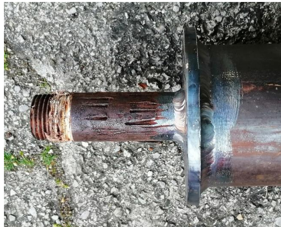
Slika 44. Zavareni spoj grane za punjenje
