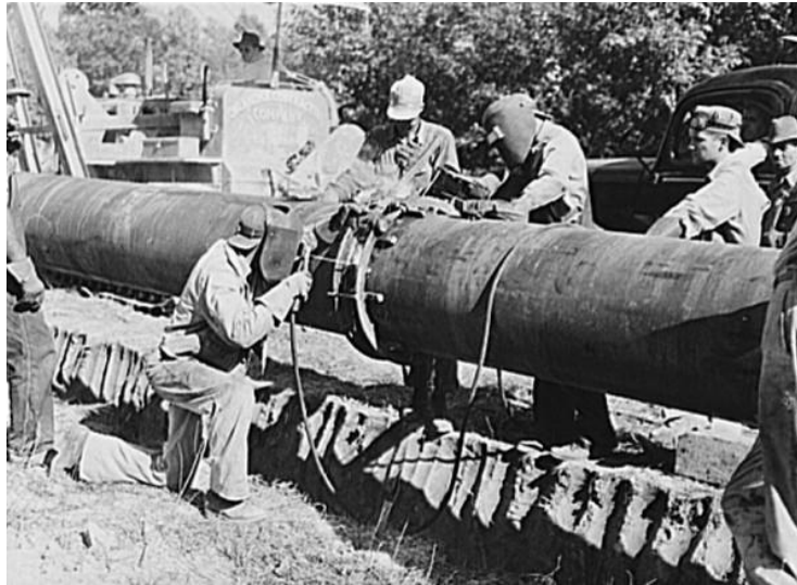
Slika 1. 1942. godina, zavarivanje cjevovoda velikih dimenzija [4]
