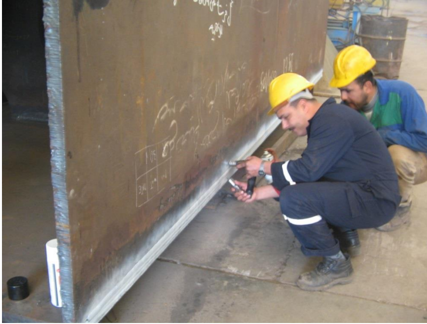
Slika 22. Izvođenje magnetske kontrole u radionici na zavaru [30]
