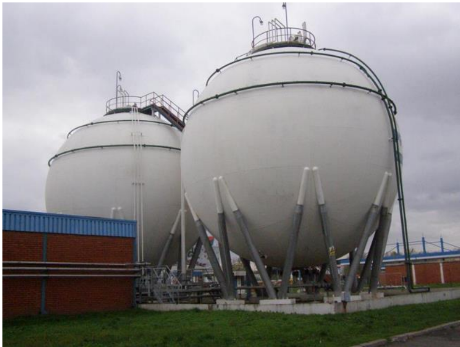
Slika 12. Kuglasti spremnik UNP-a "kugla" [2]
