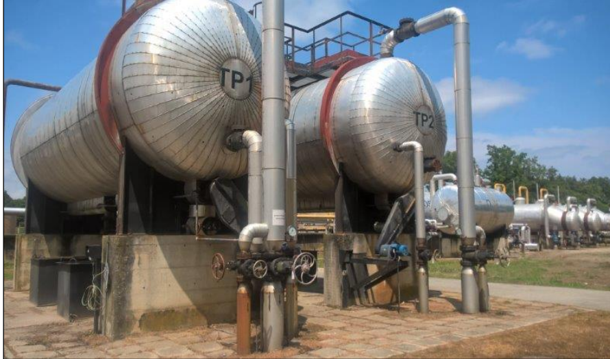
Slika 3. Taložnici pijeska TP-1 i TP-2 [2]
