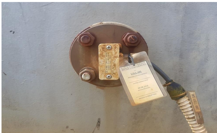
Slika 29. SMK (sklopka magnetna kontaktna)
