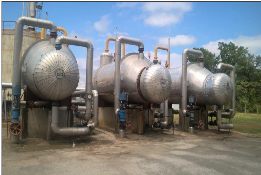
Slika 5. Izmjenjivači topline IS-3, IS-2, IS-1 [2]
