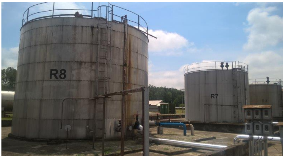
Slika 12. Spremnici slane vode ( R- 7 i R- 8 ) [2]
