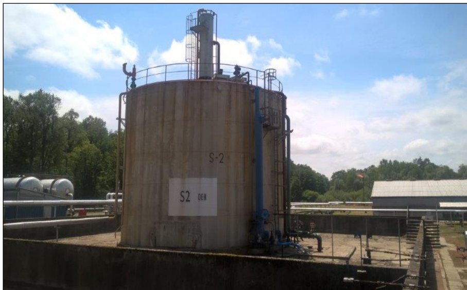
Slika 7. Dehidrator S-2 [2]
