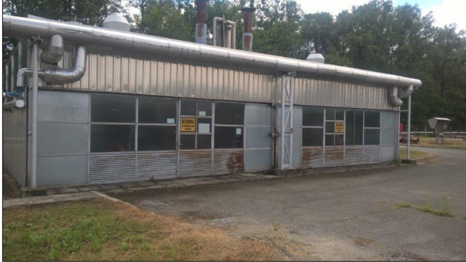
Slika 16. Kotlovnica OS Žutica [2]
