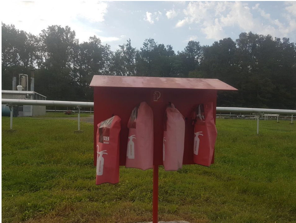
Slika 46. Nosači prijenosnih vatrogasnih aparata
