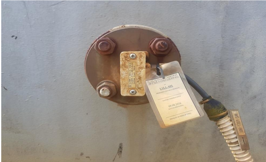
Slika 29. SMK (sklopka magnetna kontaktna)
