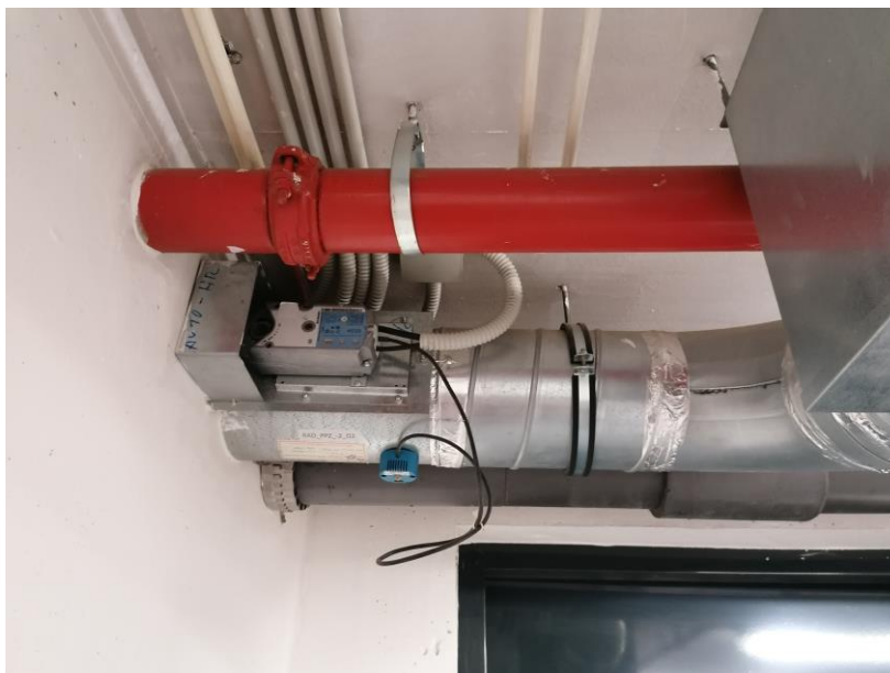
Sl. 19. Protupožarna zaklopka [24]
