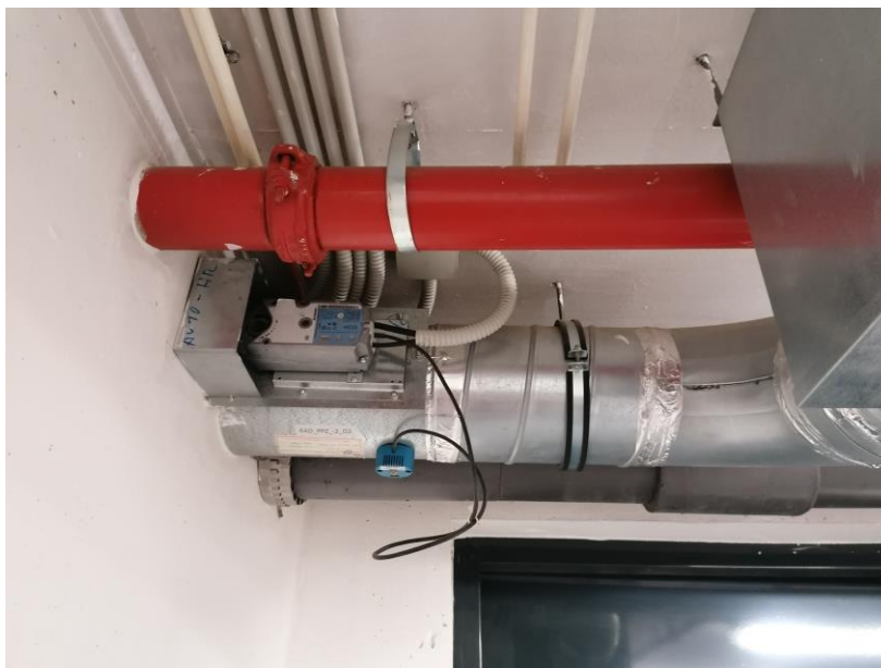
Sl. 19. Protupožarna zaklopka [24]
