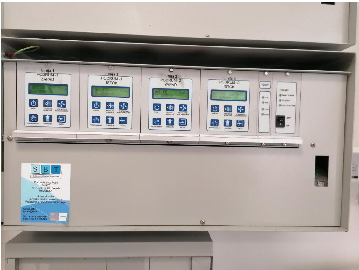
Sl. 20. Upravljačko mjerni uređaj s alarmom i detektorom plina [24]
