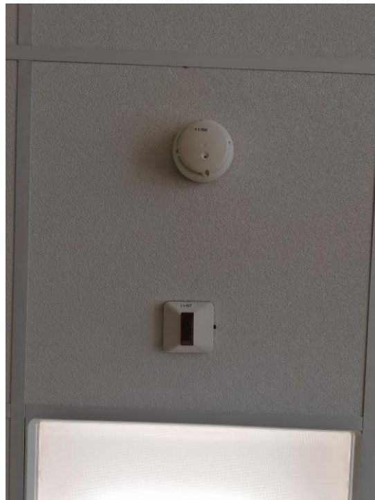
Sl. 18. Detektor požara [24]
