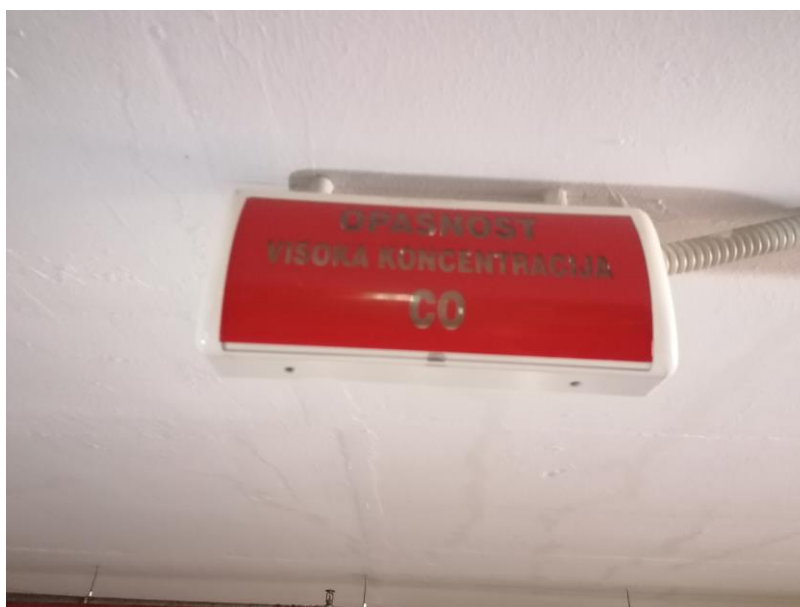
Sl. 21. Svjetlosna signalizacija opasnosti visoke koncentracije CO [24]
