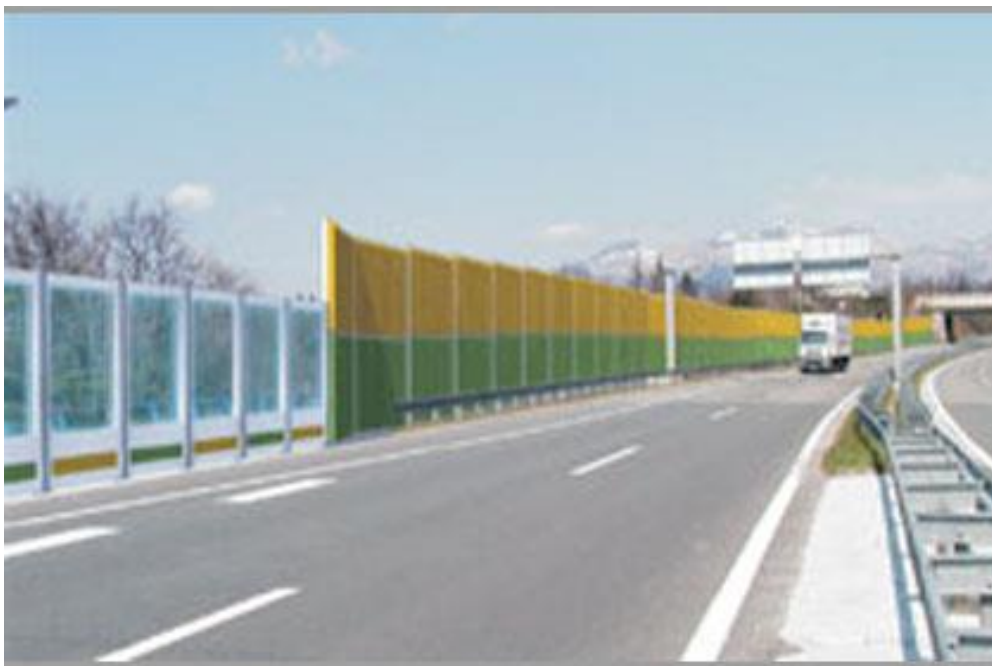
Slika 7. 2. Zidovi za zaštitu od buke
