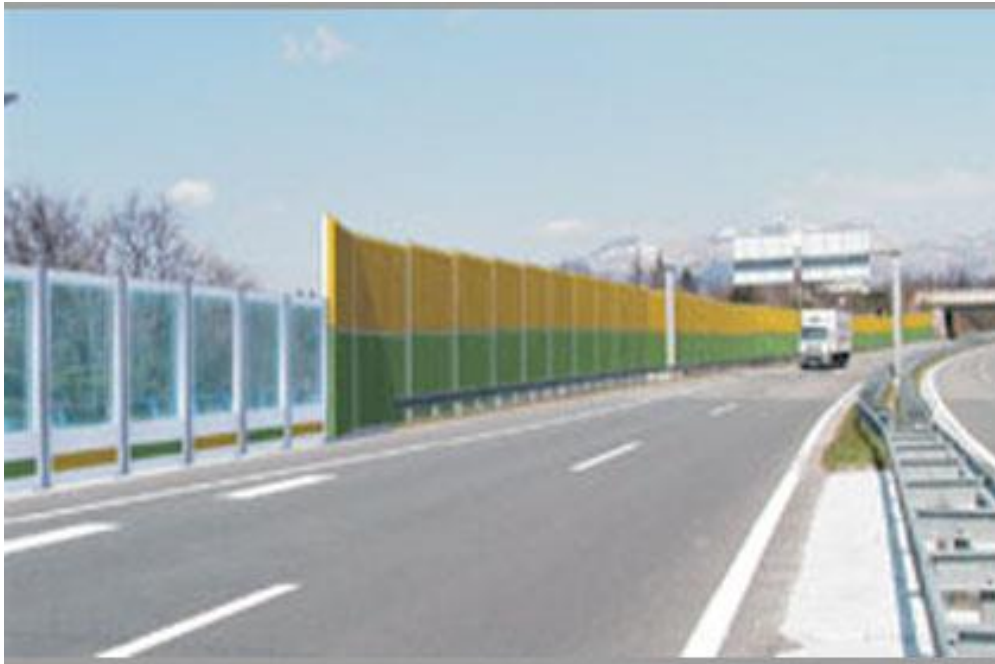
Slika 7. 2. Zidovi za zaštitu od buke
