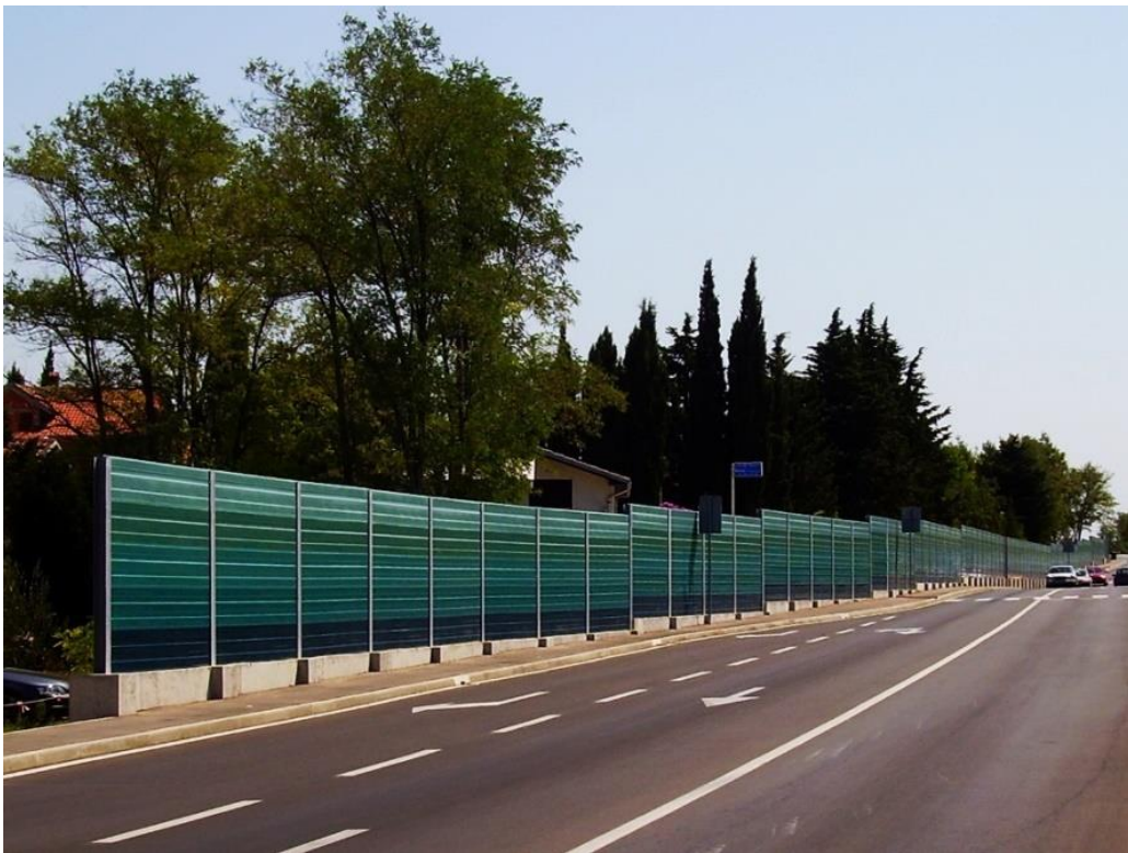
Slika 7. 3. Aluminijski paneli
