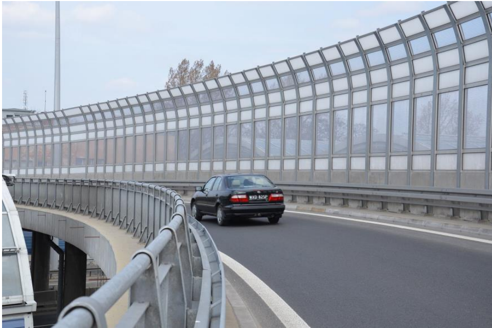
Slika 7. 4. Transparentni paneli
