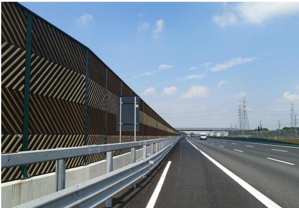
Slika 7. 5. Drveni paneli
