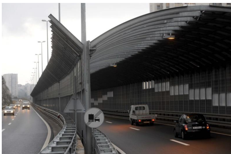
Slika 10. 2. Zid za zaštitu od buke - Rijeka
