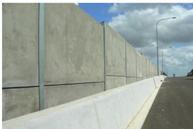
Slika 7. 7. Armirano-betonski paneli
