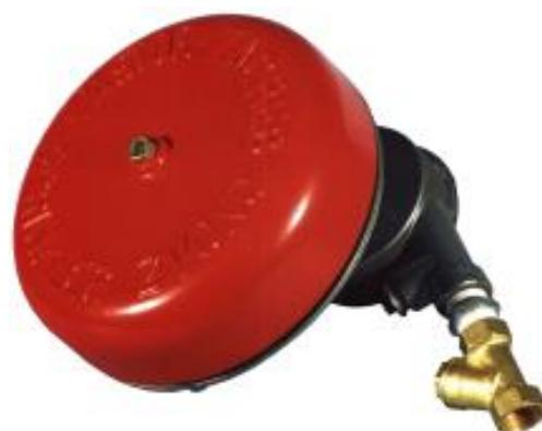
Slika 8. Hidraulično alarmno zvono [ 3 ]
