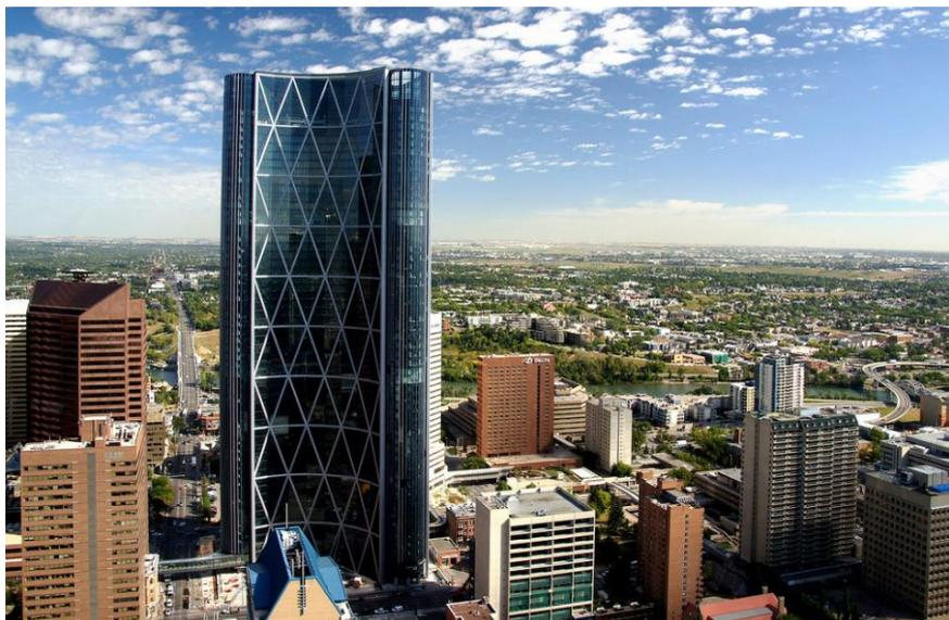
**Slika 1.6.** Primjena rešetkastih konstrukcija kod modernih građevina [6]
