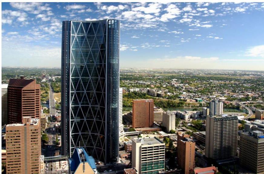
Slika 1.6. Primjena rešetkastih konstrukcija kod modernih građevina [6]
