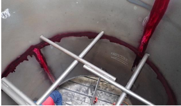
Slika 43. Ispitivanje zavora sa unutarnje strane izlazne cijevi. [2]
