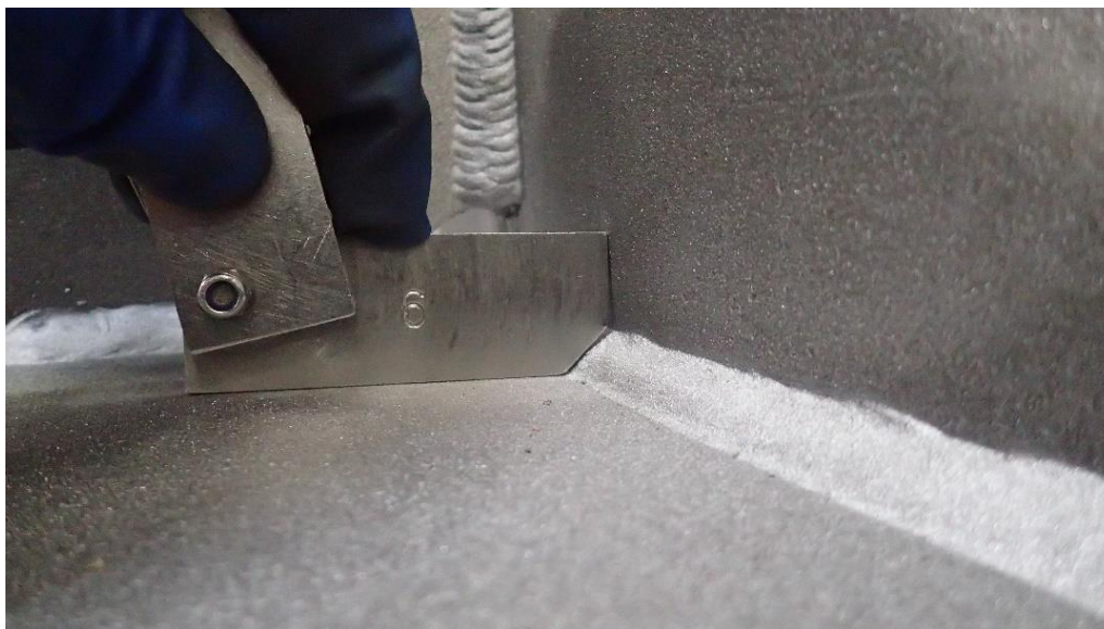
Slika 29. Kontrola visine zavora sa šablonom za zavare. [2]
