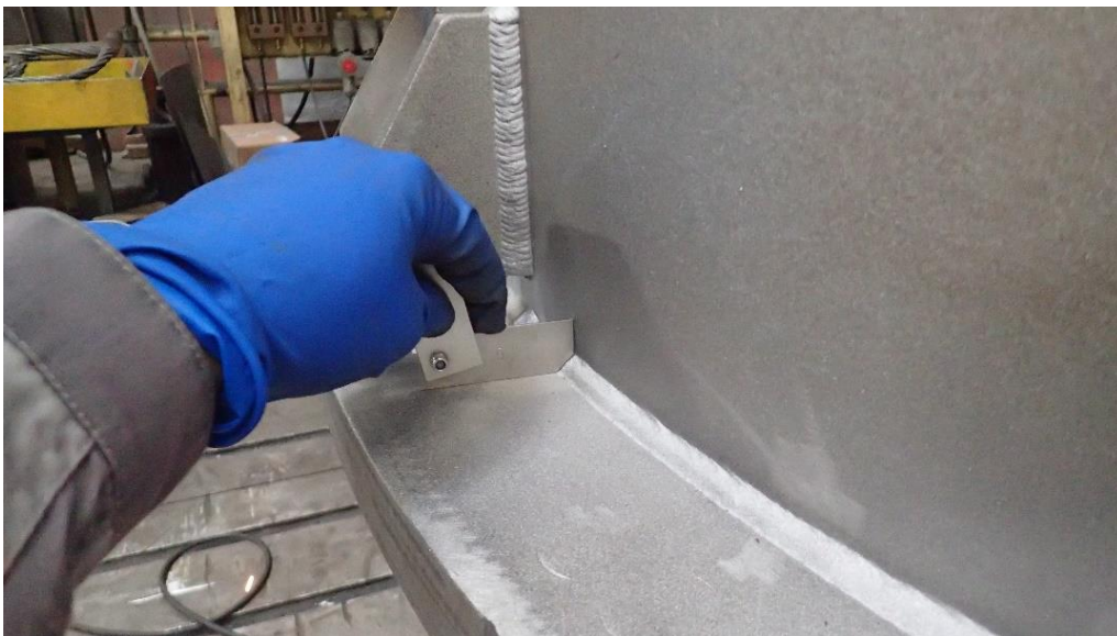
Slika 28. Kontrola visine zavara sa šablonom za zavare. [2]
