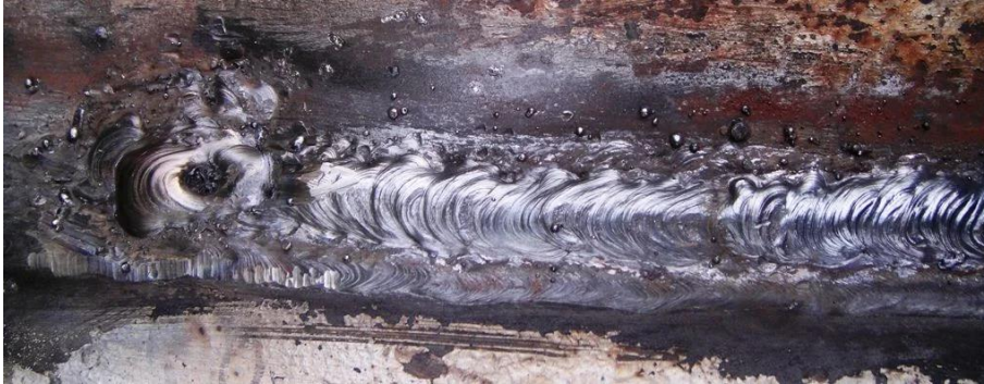
Slika 21. Primjer onečišćenja zavara kapljicama materijala. [2]
