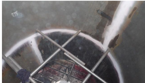
Slika 44. Ispitivanje zavora sa unutarnje strane izlazne cijevi. [2]
