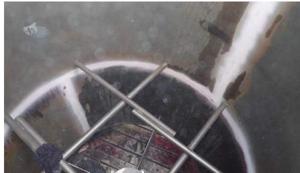
Slika 44. Ispitivanje zavora sa unutarnje strane izlazne cijevi. [2]
