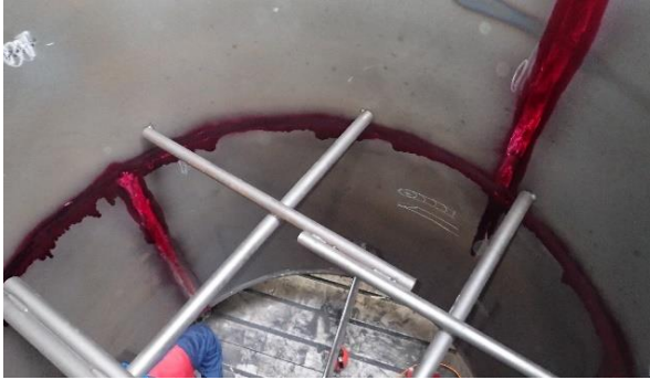
Slika 43. Ispitivanje zavora sa unutarnje strane izlazne cijevi. [2]
