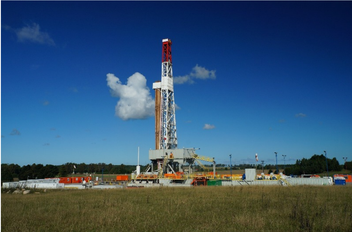
Slika 3. Prikaz stacionarnog postrojenja
