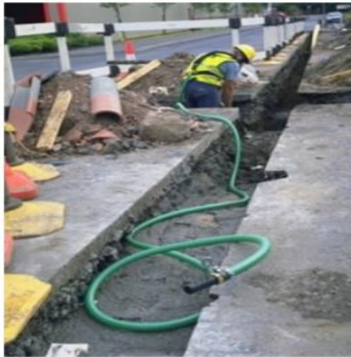
Slika 19 Cijevni uređaj sa svježim zrakom
