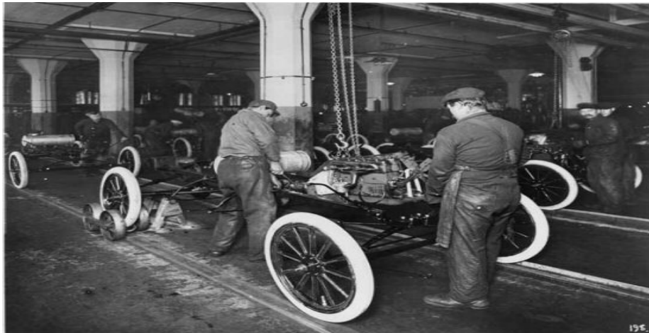
Slika 1. Sastavljanje automobila na pokretnoj traci u tvornici Ford početkom 20. stoljeća
