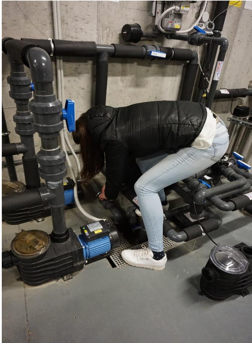
Slika 14. Ispust vode kroz sustav cijevi zbog izmjene vode u akvariju, foto: Krešimir Kuri
