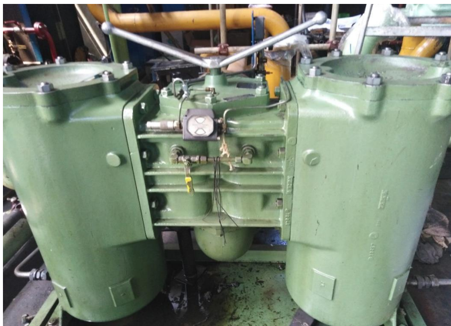
Slika 27. Predodžba čeličnih filtera ulja s magnetom ( 0,03 mm finoća )
