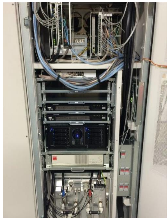
Slika 9. Predodžba kontrolnog ormara s RF pojačalom. Izvorno autor.
