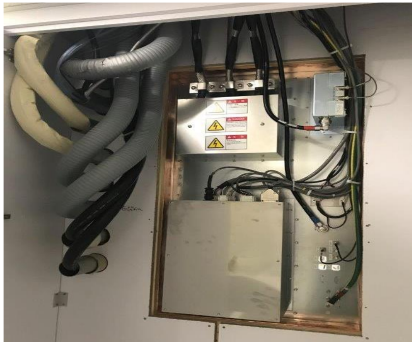
Slika 3. Predodžba filter panela. Izvorno autor.
