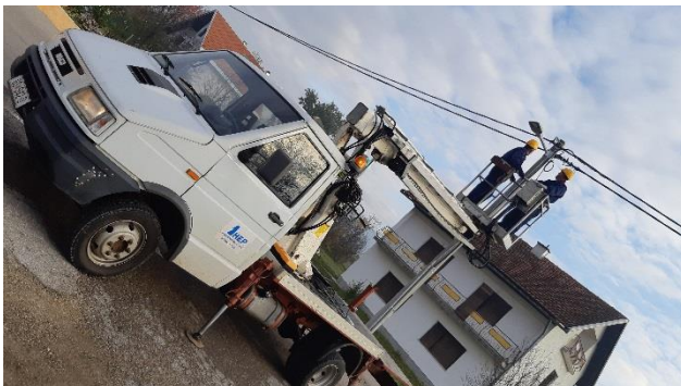
Slika 13. Prikaz popravka električne instalacije u beznaponskom stanju na javnoj rasvjeti
