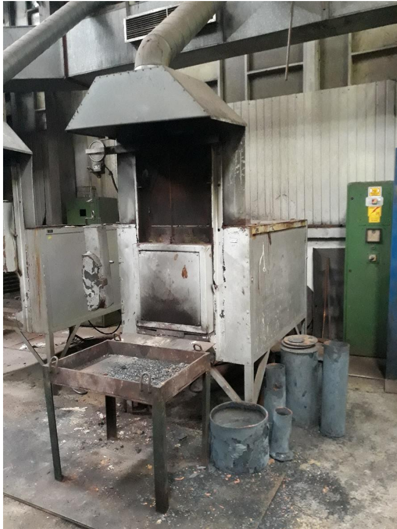
Slika 22. Komorna elektro peć [10]
