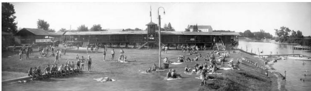
Slika br. 8: Kupalište i kupališne zgrade
